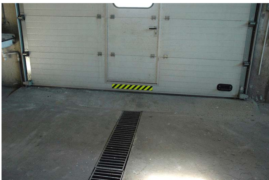
Fot.16 – Zjazd z poziomu podstawy bramy do środka hali od strony wschodniej
