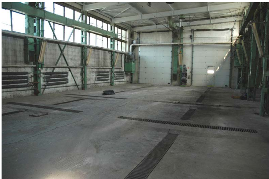
Fot.1 - Widok ogólny na halę od strony wschodniej.
