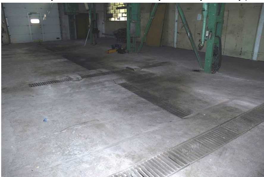
Fot.6 – Kanały pomocnicze i główne w części środkowej od strony północnej
