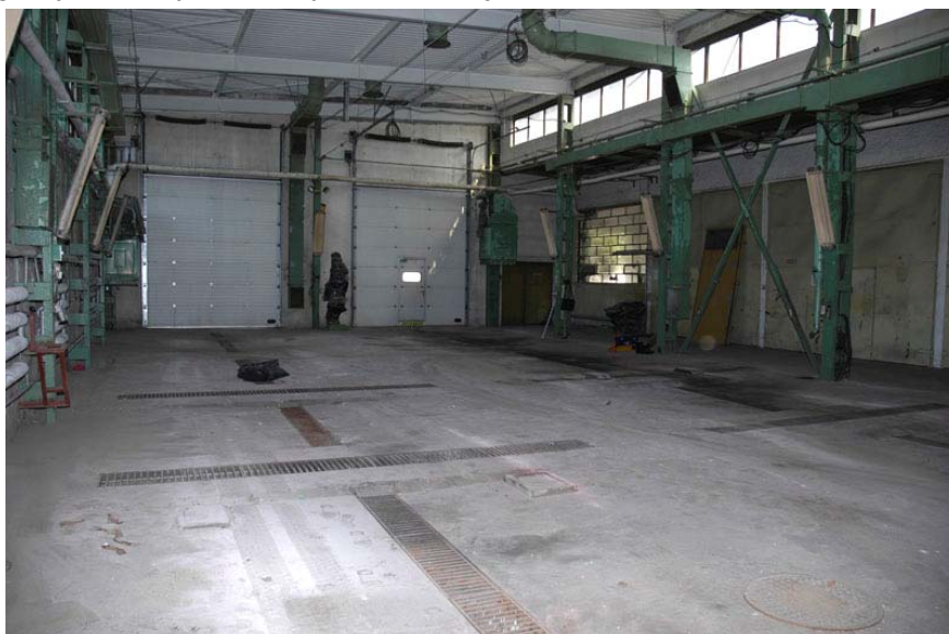
Fot.2 - Widok ogólny na halę od strony wschodniej (po prawej nawa niższa z ciągiem komunik.)
