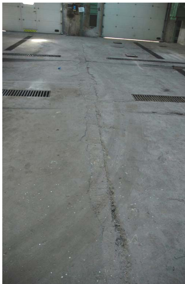
Fot.10 i Fot.11 – Uszkodzenia posadzki wzdłuż osi podłużnej hali
