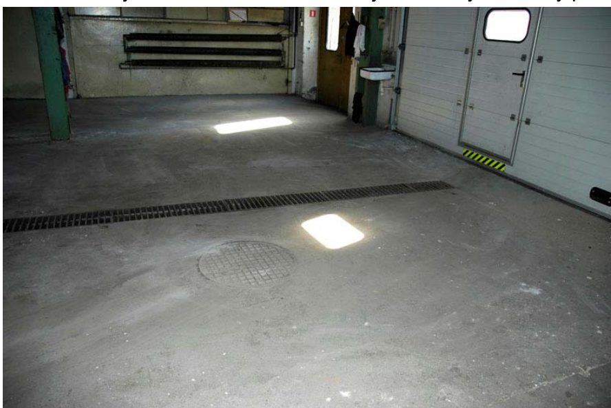
Fot.5 - Studzienka kanalizacji i odwodnienie liniowe w rejonie bramy od strony północno – wsch.
