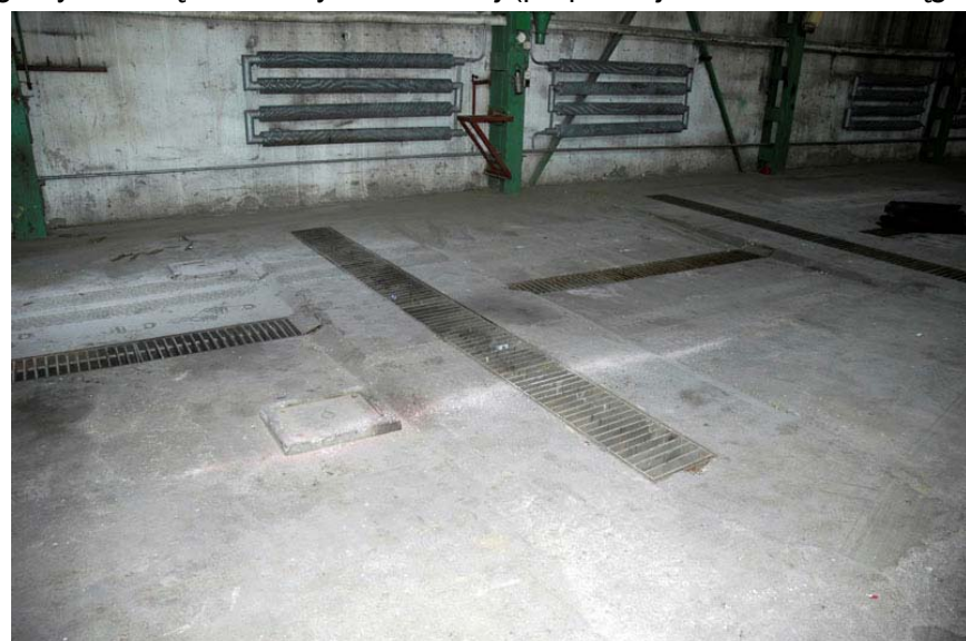
Fot.3 - Kanał pomocniczy w części środkowej od strony południowej.
