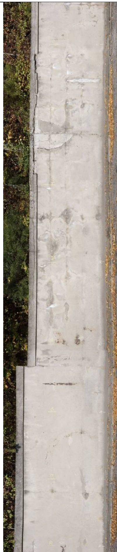
Odcinek od 72,0 do 90,0 m
