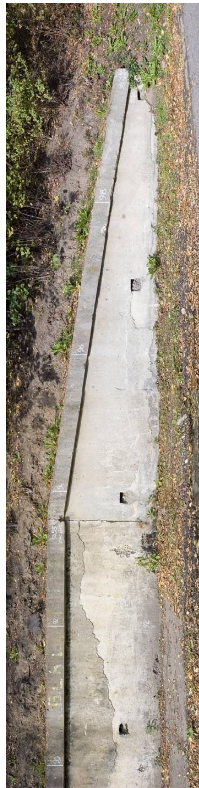
Odcinek od 72,0 do 90,0 m
