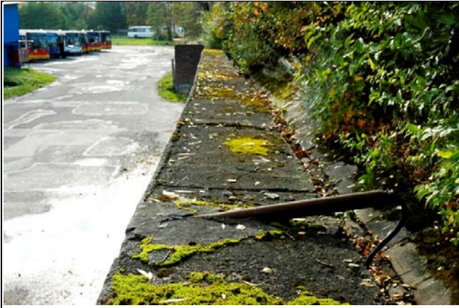
Widok ogólny na czapę wieńczącą mur
