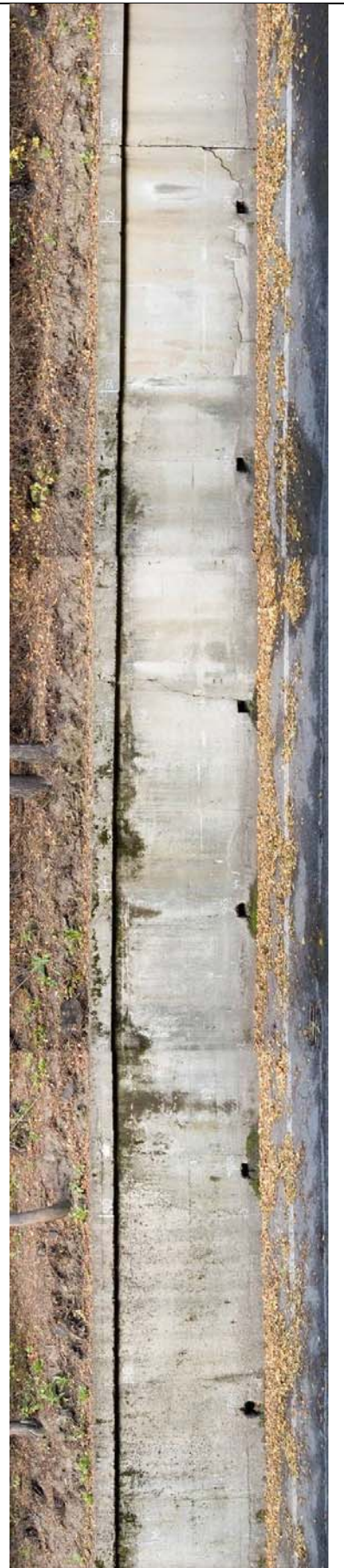
Odcinek od 18,0 do 36,0 m
