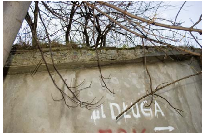
Fot 5 i 6 Uszkodzenia korony ściany segmentu 1
