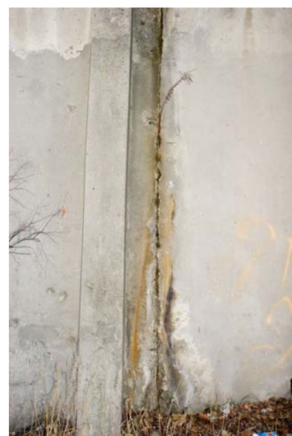
Fot. 23 i 24 – Uszkodzenia konstrukcji krawędzi segmentu w miejscu dylatacji, widoczna niejednorodna powierzchnia ściany
