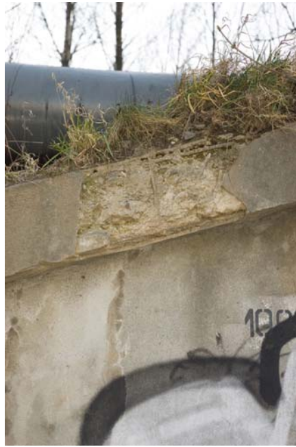
Fot 7, 8 i 9 Uszkodzenia korony ściany segmentu 1
