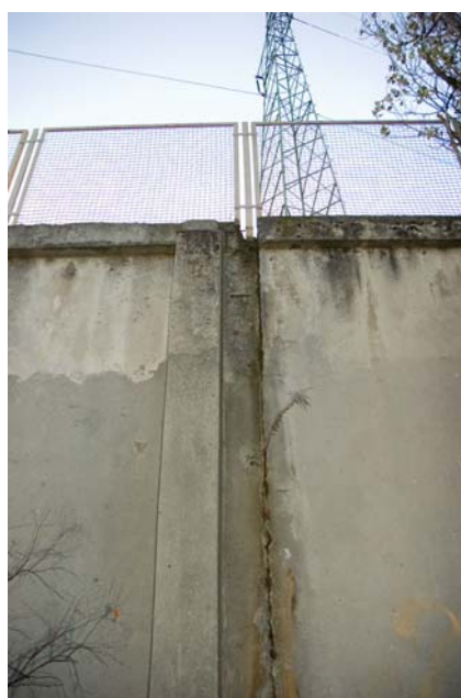
Fot. 23 i 24 – Uszkodzenia konstrukcji krawędzi segmentu w miejscu dylatacji, widoczna niejednorodna powierzchnia ściany
