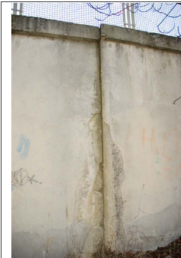
Fot 1 i 2. Przesunięcie w styku segmentu nr 7 i 8
