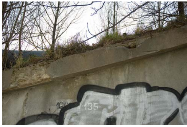
Fot 5 i 6 Uszkodzenia korony ściany segmentu 1
