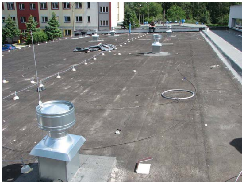
Fot.2 - Widok ogólny na dach hali niższej od strony północno zachodniej
