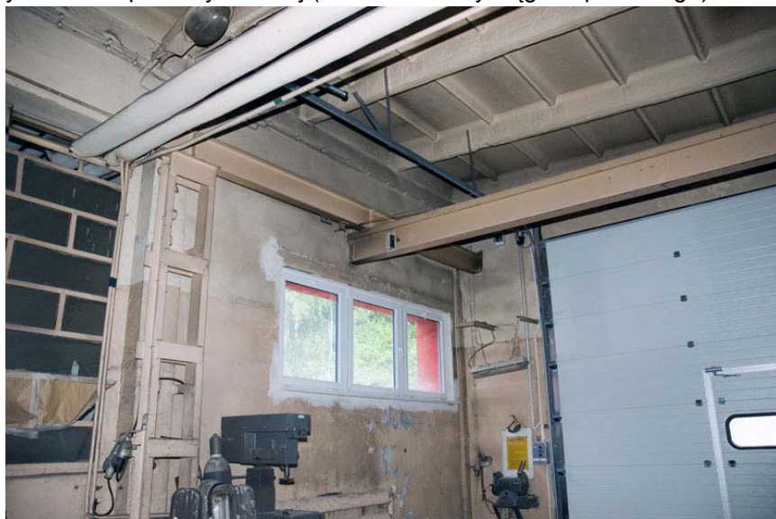
Fot.9 – Widok konstrukcji nośnej oraz istniejącego doświetlenia w rejonie bramy wjazdowej hali.
