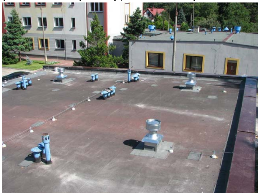
Fot.3 - Widok ogólny na dach części socjalnej hali niższej od strony północno zachodniej
