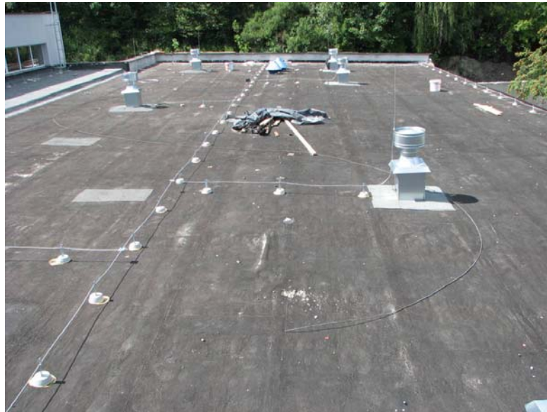
Fot.1 - Widok ogólny na dach hali niższej od strony południowo-wschodniej
