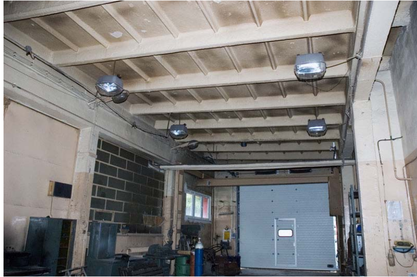
Fot.4 – Widok konstrukcji nośnej hali i stropodachu od wewnątrz (w części ciągu naprawczego hali) w kierunku bramy wjazdowej (strona pn-zach).
